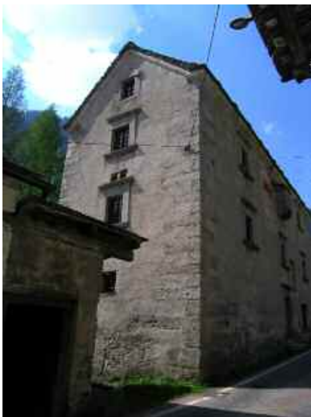
Fig. 20. Casa-forte con alloggio (Ponte, Val Formazza).
